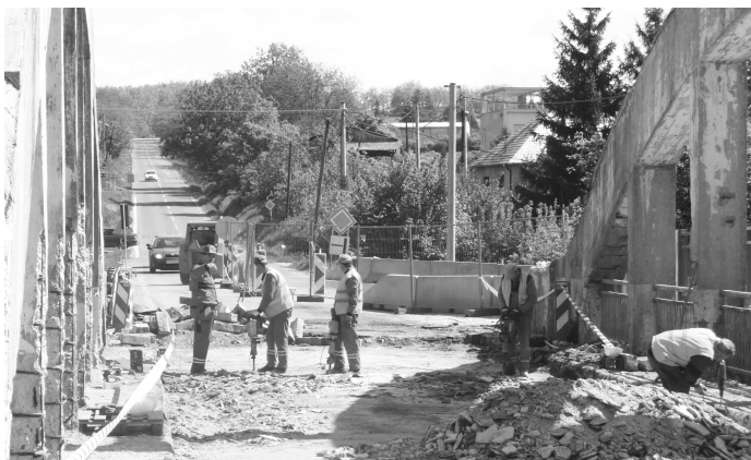
Pracovníci so zbijačkami - zatiaľ nič nenasvedčuje tomu, že by sa starý most nemal rekonštruovať. Stredom starého mosta by ešte v blízkej budúcnosti mali vybudovať akýsi "lešenársky tunel", ktorý bude určený pre chodcov, keďže nový most nie je pre tento účel bezpečný.
