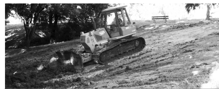
● Nebezpečné strže v parku Hôrka zasypávali zeminou vykopanou pri budovaní obchodného centra
